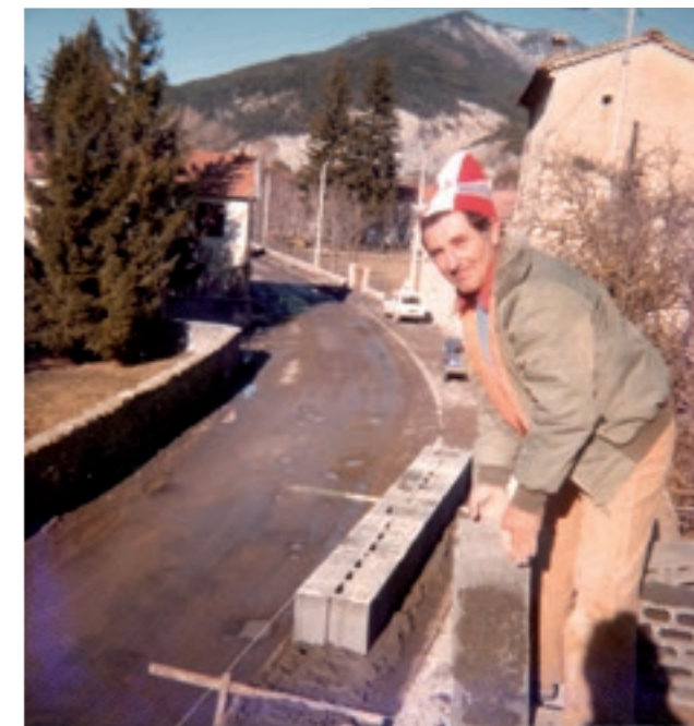
travaux au croisement du Mazet
