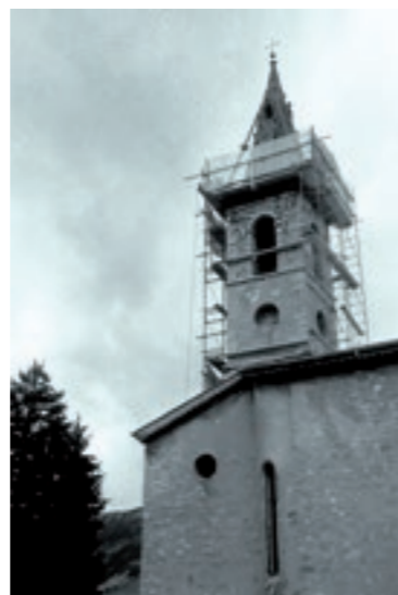
1963, travaux de rejointage du clocher
