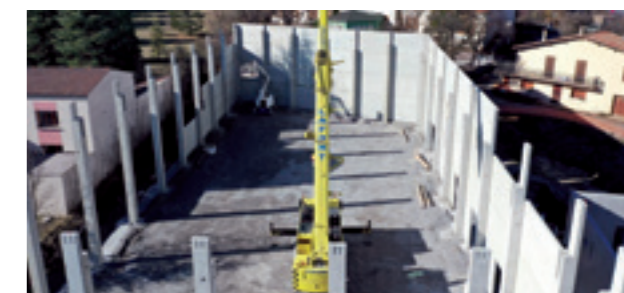
Travaux du gymnase de Saint-André-les-Alpes
