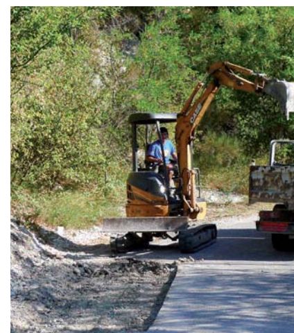
Travaux voirie route de Chalvet
