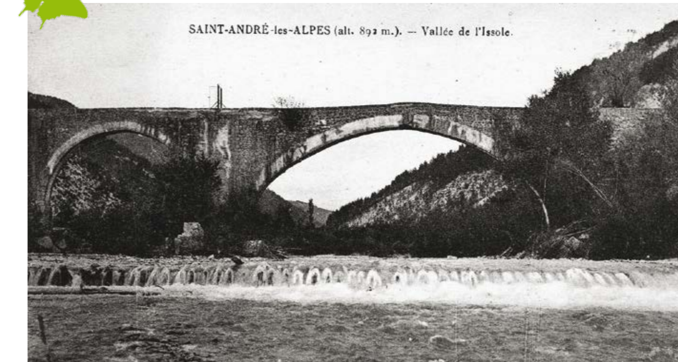
La prise du Canal du moulin réalisée par Amable et Joseph Bourrillon en 1919
