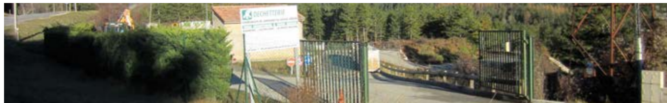
Déchetterie de La Mure-Argens.
