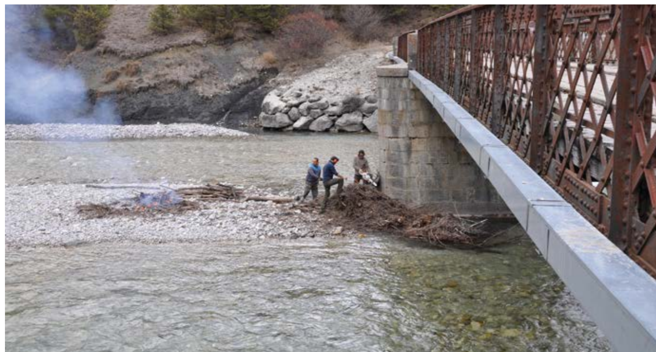
Intervention Pont de Méouilles
